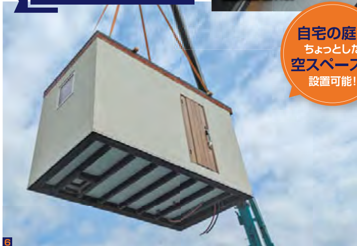
6.本社工場で製造され、完成後に丸ごと移動。北海道から沖縄まで運搬可能な自由度も魅力。
